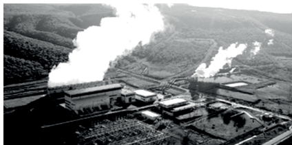
Central geotérmica de Ol Karia
