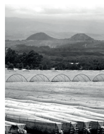
Invernaderos con calefacción geotérmica para las granjas de cultivo de flores
